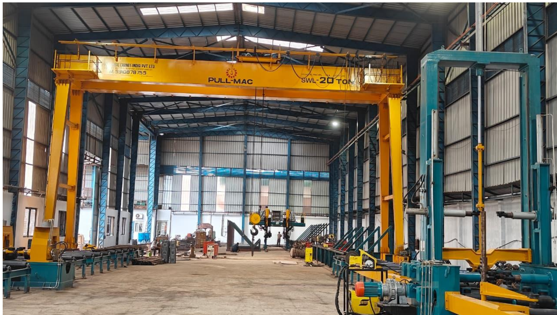
EOT CRANE 20 TON
